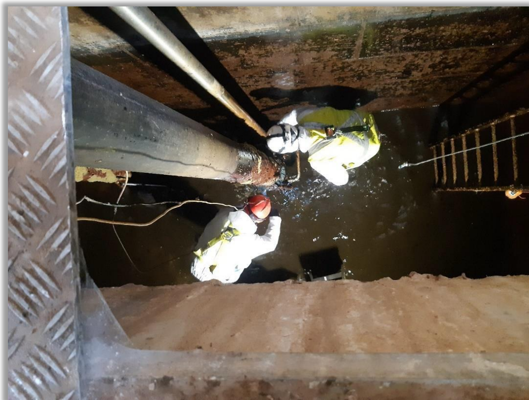
Foireann Seirbhísí Uisce Chomhairle Contae an Longfoirt ag obair i spás teoranta deartha le trealamh tarrhála i bhfeidhm.
