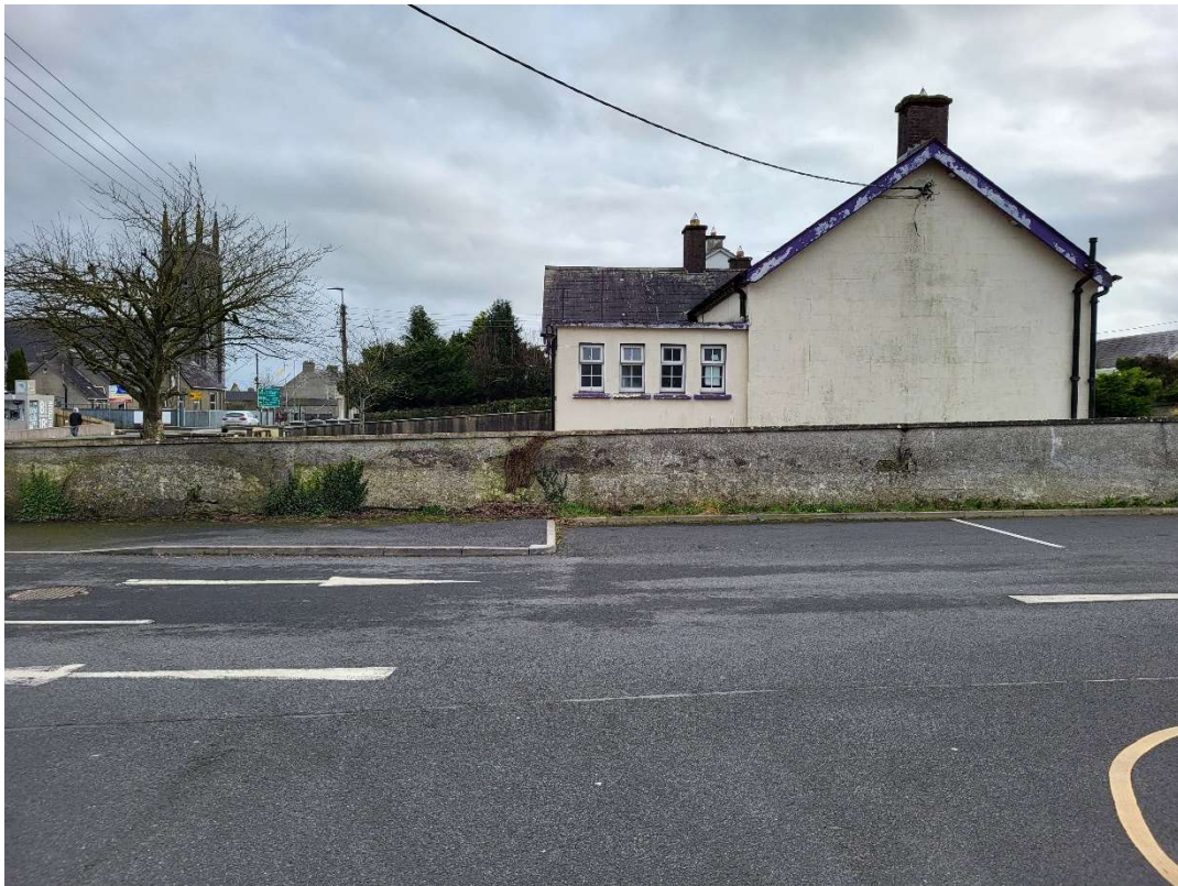
KLA – Image of side elevation of Scoil Náisiúnta Naomh Colmcille
