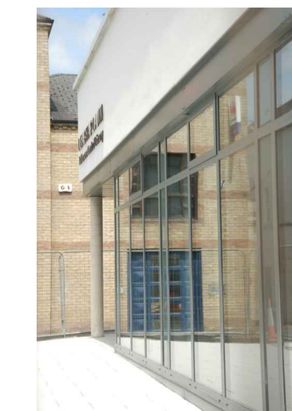
Glazing (Tullamore Library)
